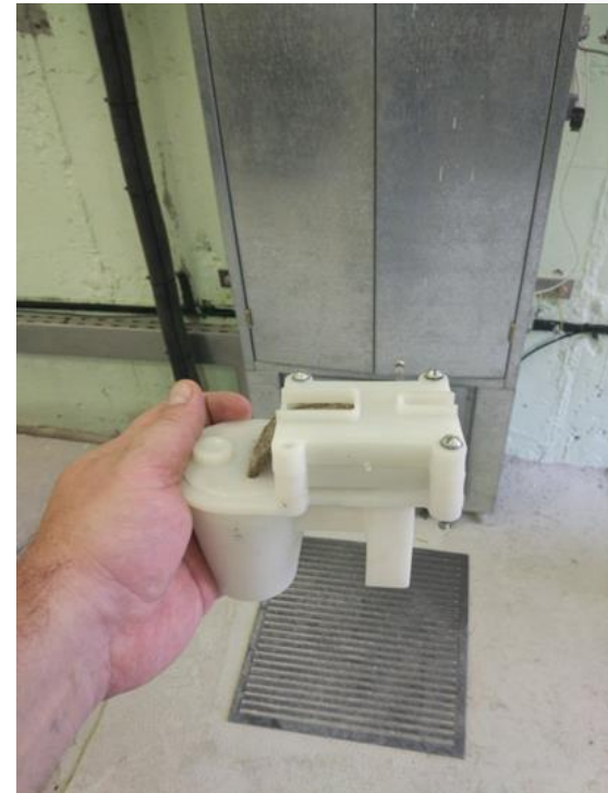
установка новых масленок
