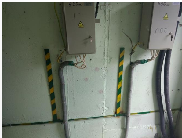
закрепление кабелей электропитания и контура заземления (с покраской)
