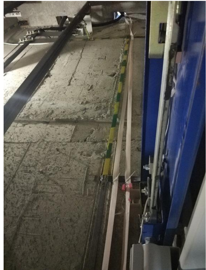
восстановление проводки по шахте
