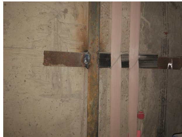
монтаж и крепление заземления и проводки
